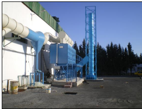
Figure 38 : dépoussiéreur à cartouches filtrantes
