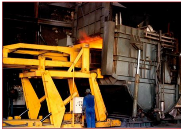
Figure 36 : four pour traitement des câbles armés
